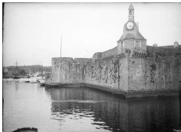
Beffroi, côté sud depuis le quai Peneroff
