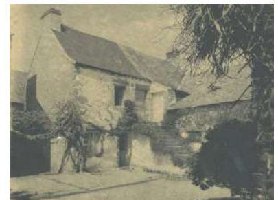
Immeuble :Vue partielle des façades (2)
