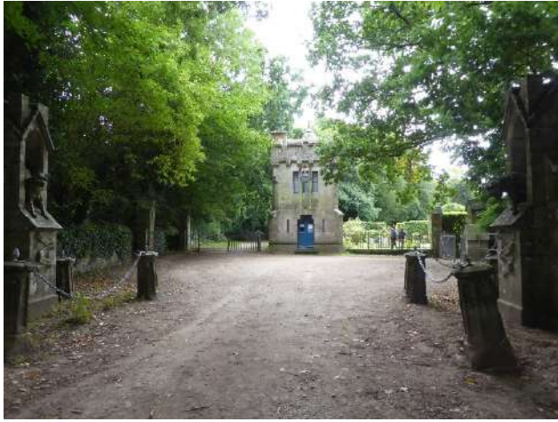
3-Maison du garde
