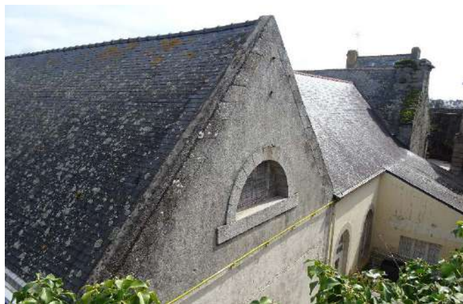
4-Vue sur l'arrière de la caserne Hervo, depuis les remparts de la Ville-Close
