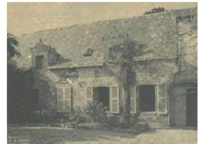
Immeuble :Vue partielle des façades
